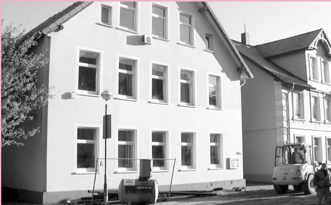
Einmal ganz wörtlich: Baustelle Brückenbau!
