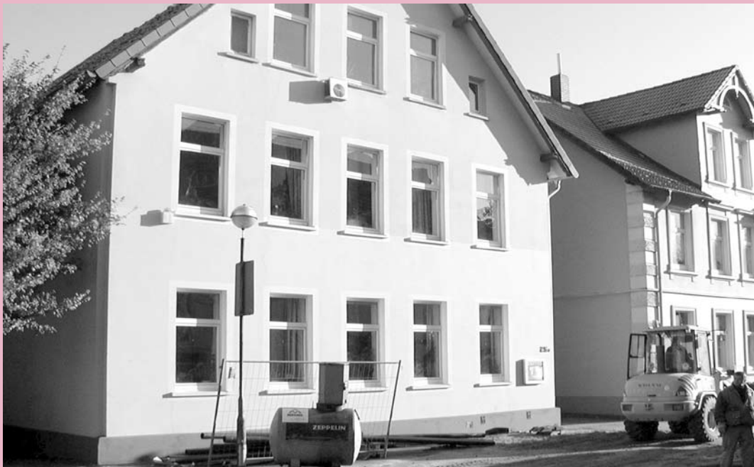
Einmal ganz wörtlich: Baustelle Brückenbau!
